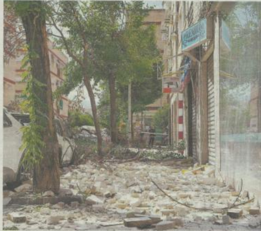
Imagen de destrozos por el último ciclo sísmico en la vecina Granada. A. PRIOS
